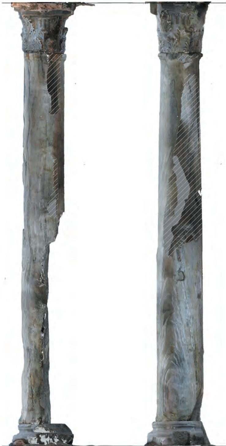
Fotogrametrijski snimak stanja stupova, baza i kapitela istočne lože portika (Neir d.o.o. 2022.)
